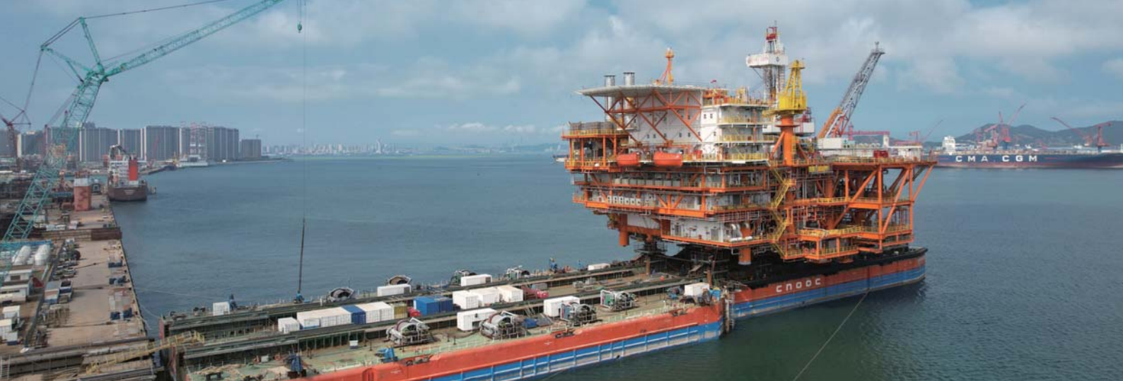
△ 旅大 6-2 油田开发工程项目 CEPA 组块装船
