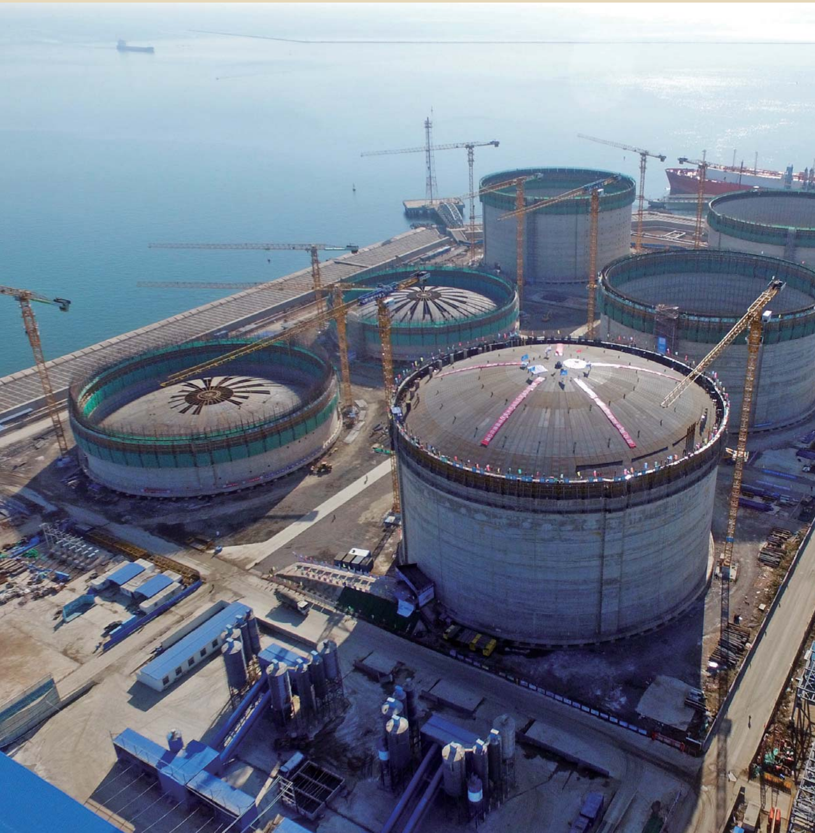
▽ 天津 LNG 二期接收站工程项目 8 号储罐升顶
