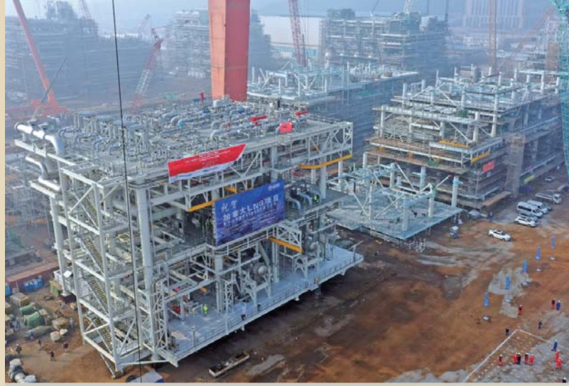
北美壳牌 LNG 模块建造项目 首个核心工艺模块完工
