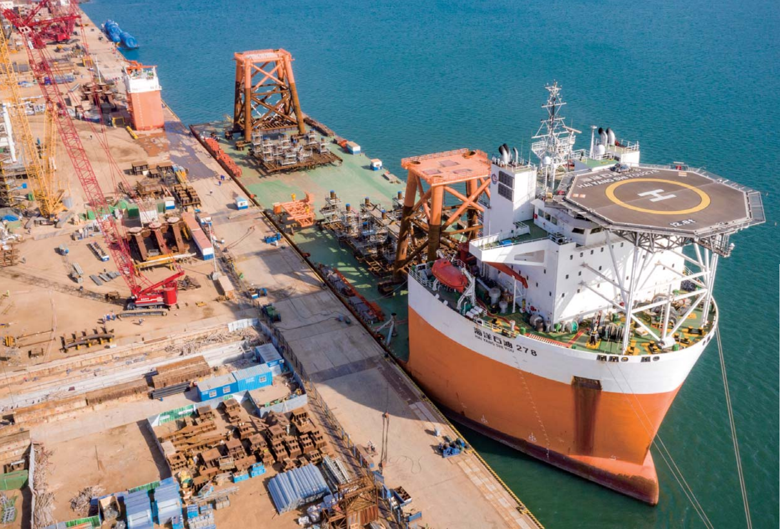
△ 香港海上液化天然气接收站项目 导管架装船
