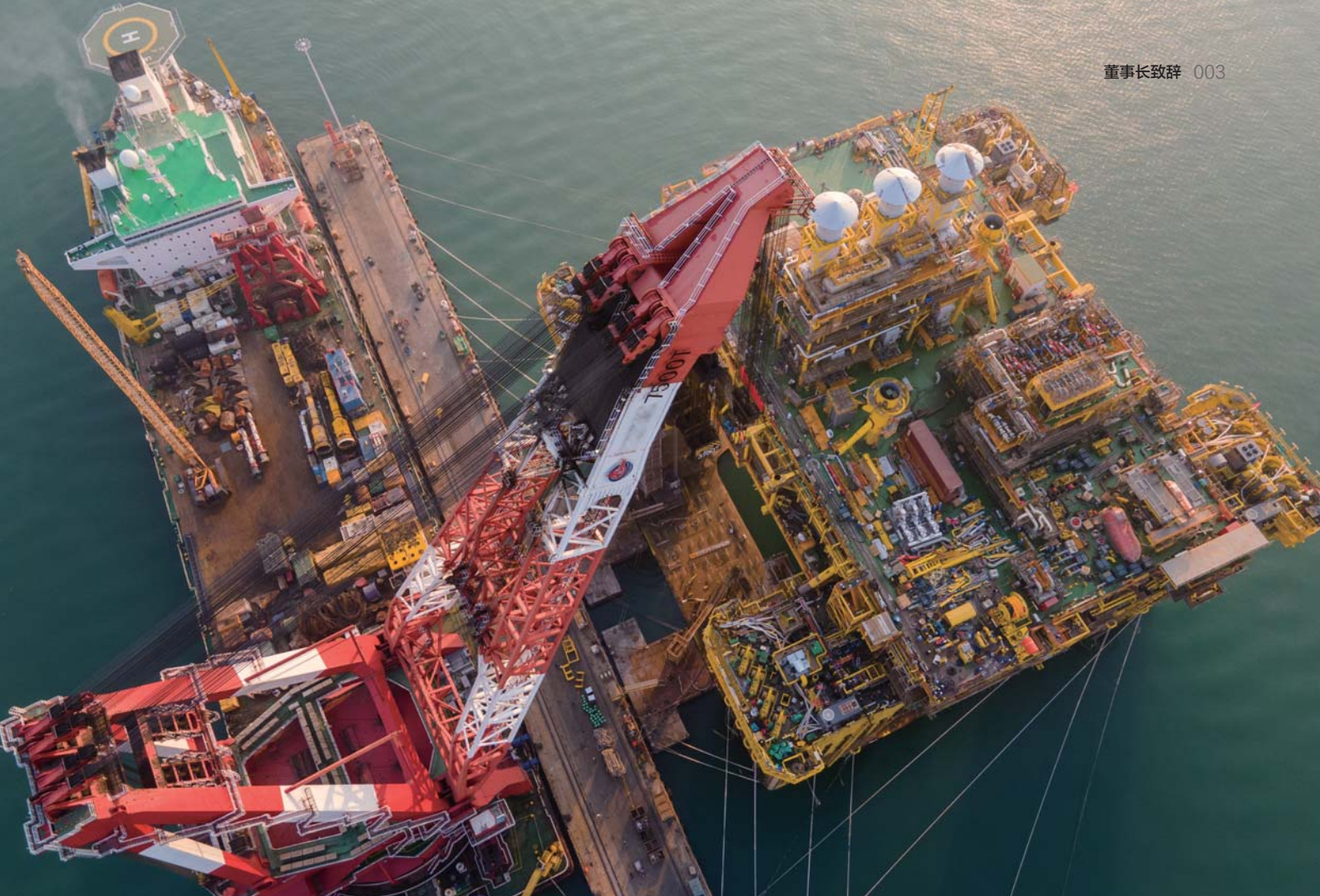
△ 陵水 17-2 气田开发工程项目 建造吊装
