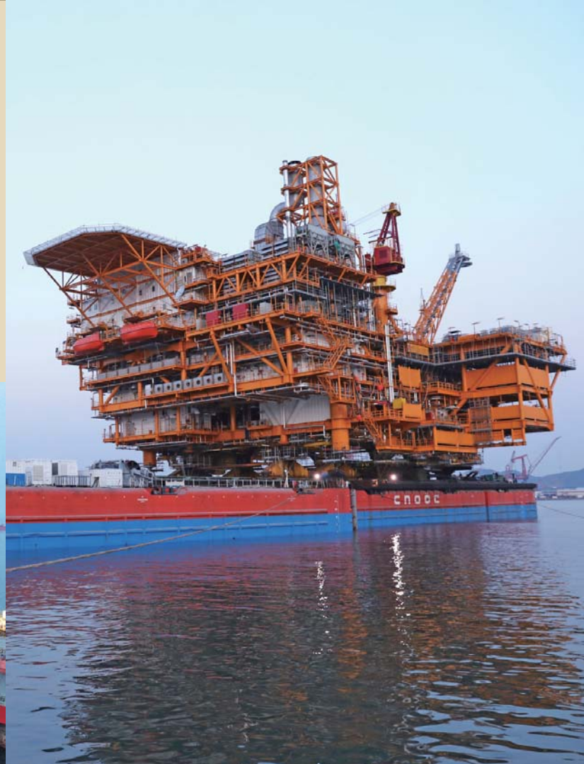
▷ 曹妃甸 6-4 油田开发工程项目 CEPA 组块陆地拖拉装船
