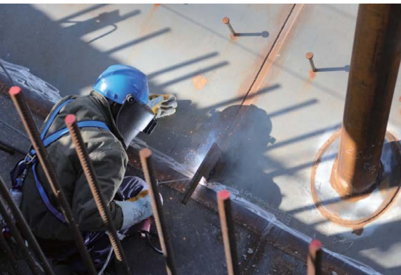
▽ 天津 LNG 二期接收站工程项目 焊接作业现场
