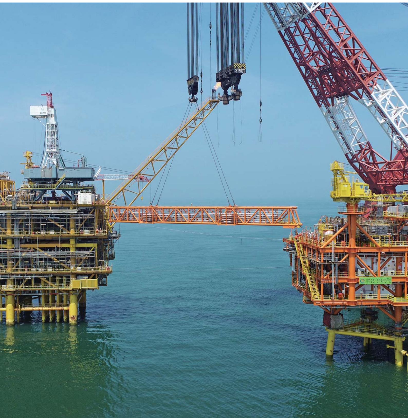
▽ 渤中 26-3 油田扩建项目 PAPD 组块海上安装
