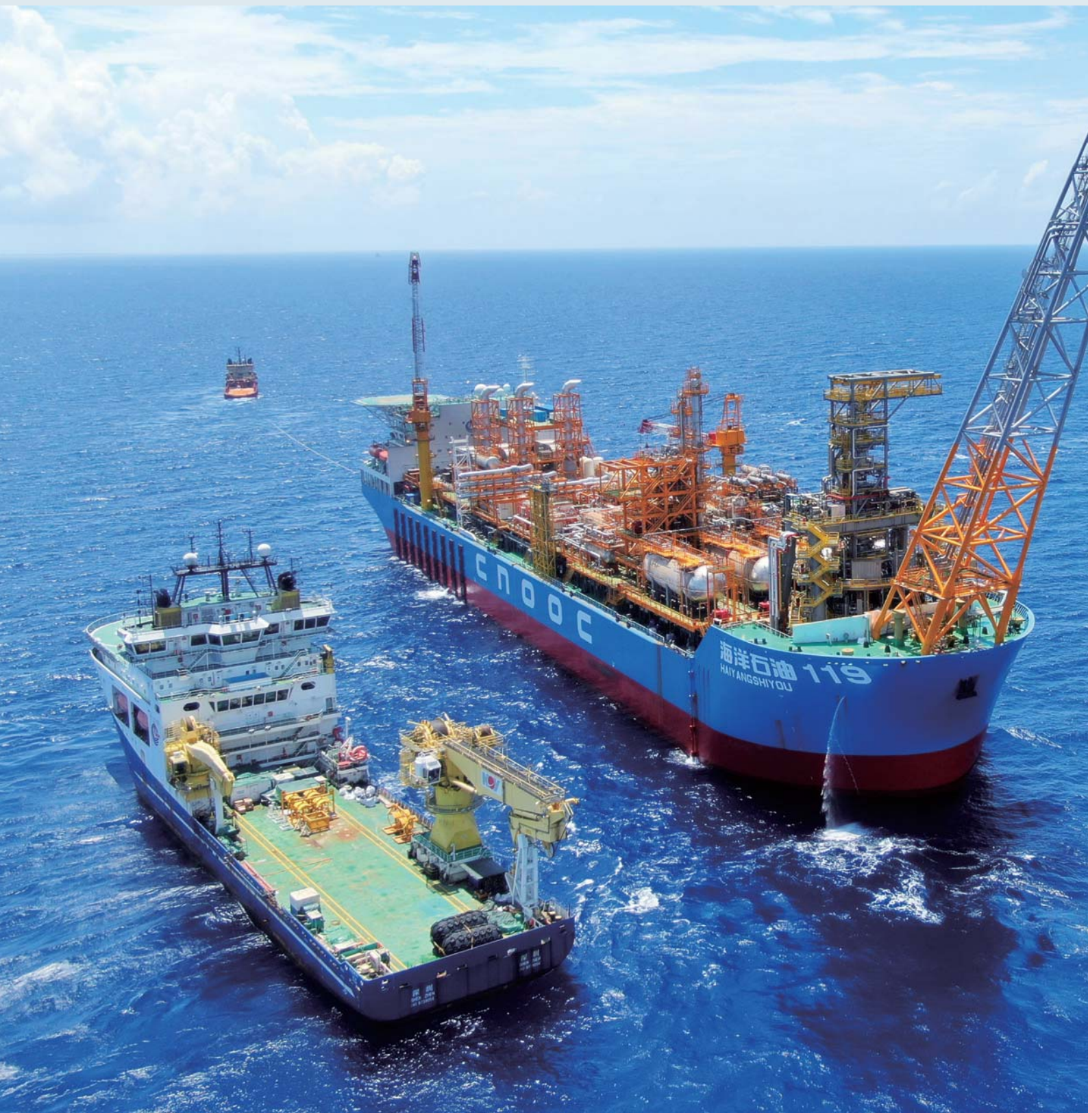
▽ 流花 16-2 油田群工程项目 FPSO 安装现场
