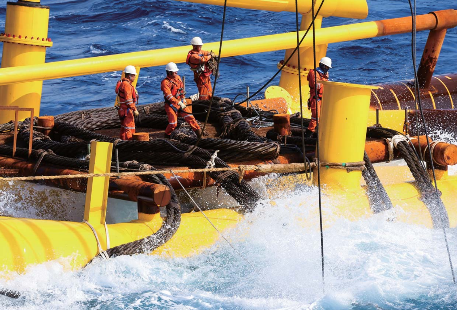
△ 陆丰油田群 14-4 工程项目 海上安装
