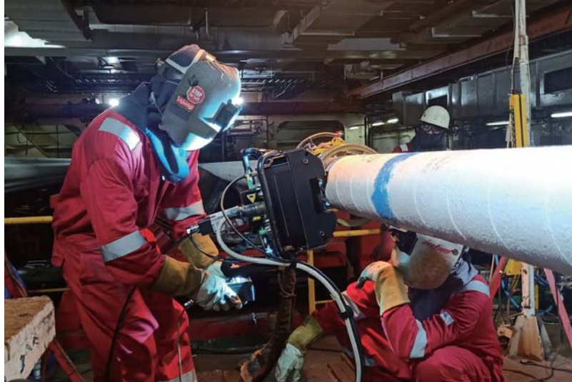
▷ 海管焊接作业
